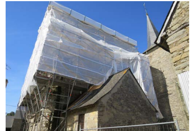
Mise en place des échafaudages et parapluie
