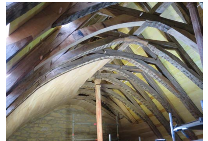
Pose de la voûte
