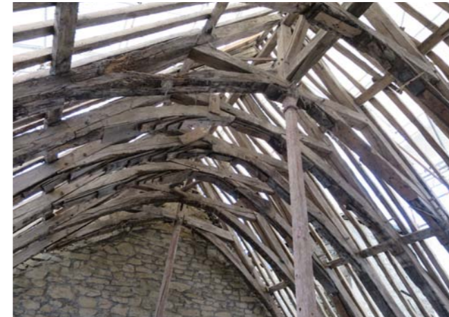
Charpente avant restauration
