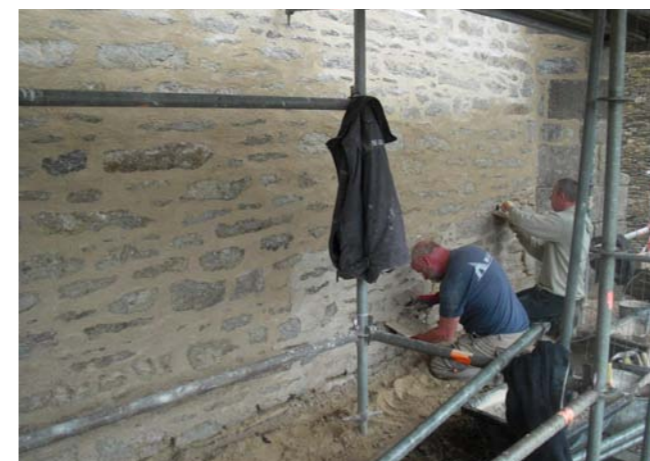
Rejointoiement extérieur au mortier de chaux
