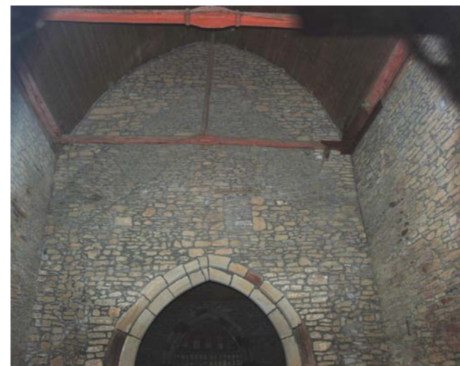
Pignon intérieur diaphragme chœur-nef
