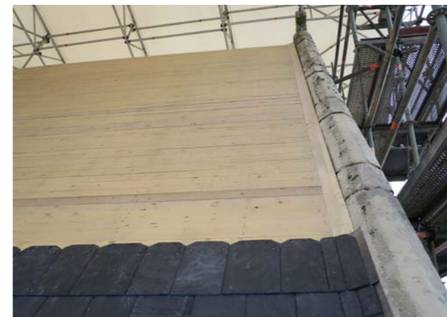
Pose de la couverture en ardoises épaisses
