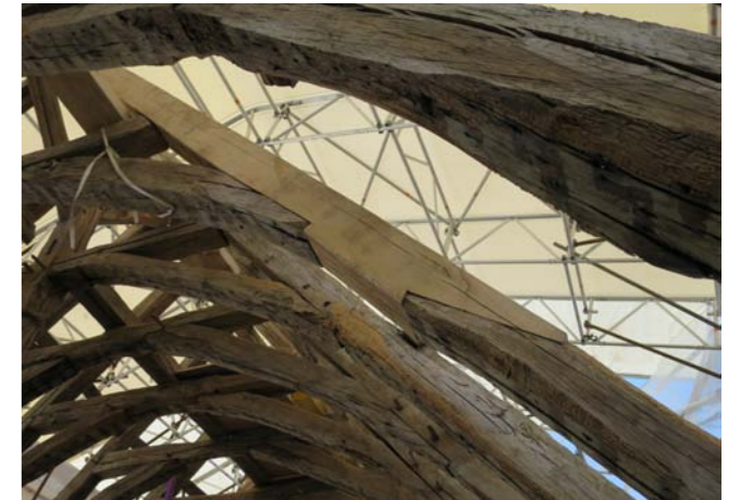
Charpente en cours de restauration
