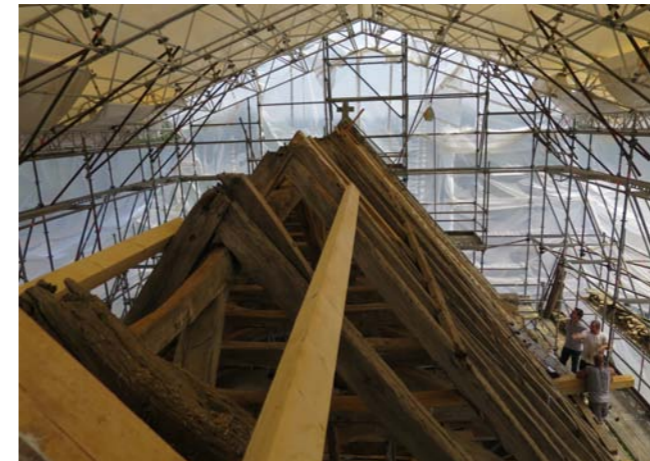
Charpente en cours de restauration
