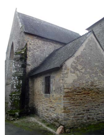
Vue Nord - sacristie et chœur
