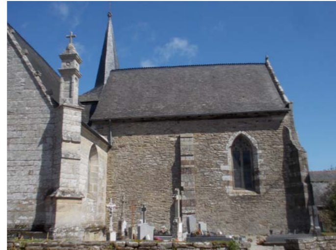
Mur Sud du chœur
