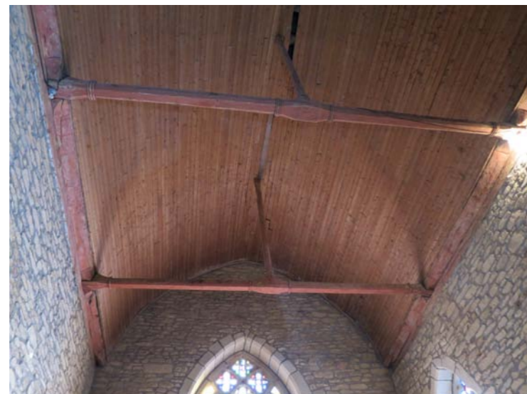
Voûte du chœur
